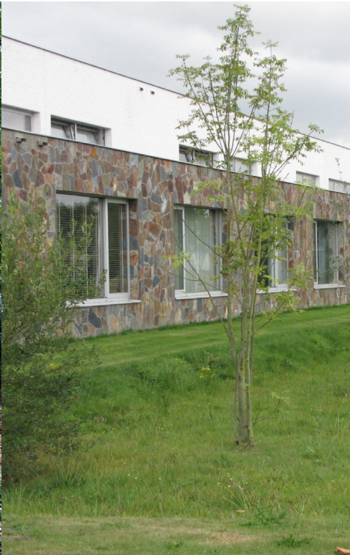
laagtes voor de opvang van regenwater, voorkomen van afstroming
