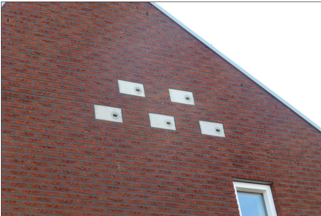
Figuur 4.5 Voorbeeld van een kopgevel met inmetzelstenen geschikt voor gierzwaluw. Foto: Ecogroen.
