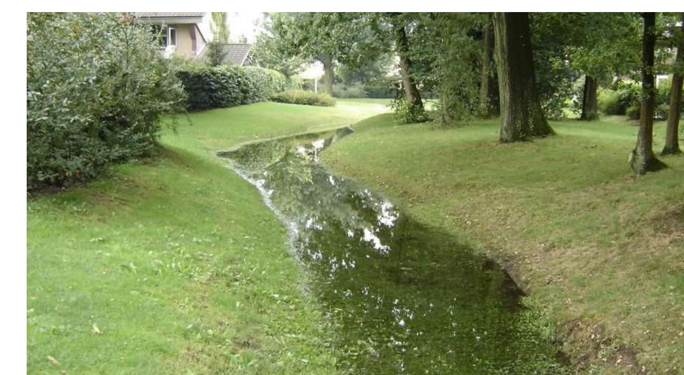
wadi; infiltratie hemelwater
